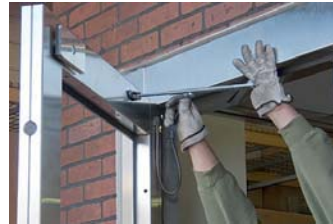
Separating door closer arm
